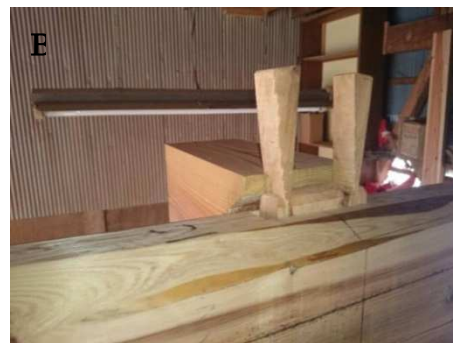
B:柱の頭に楔を打ち、留める方法 横から込み栓を叩き込む事が小屋組になるとしにくいので、叩きやすい頭から叩き入れる方法
