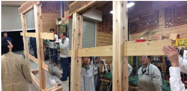
貫穴に工夫:上部を下に湾曲させる事により、よりキツくできる
