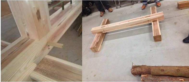
込み栓穴の工夫:柱全体を若干土台に引き付けることにより柱足元が安定する
